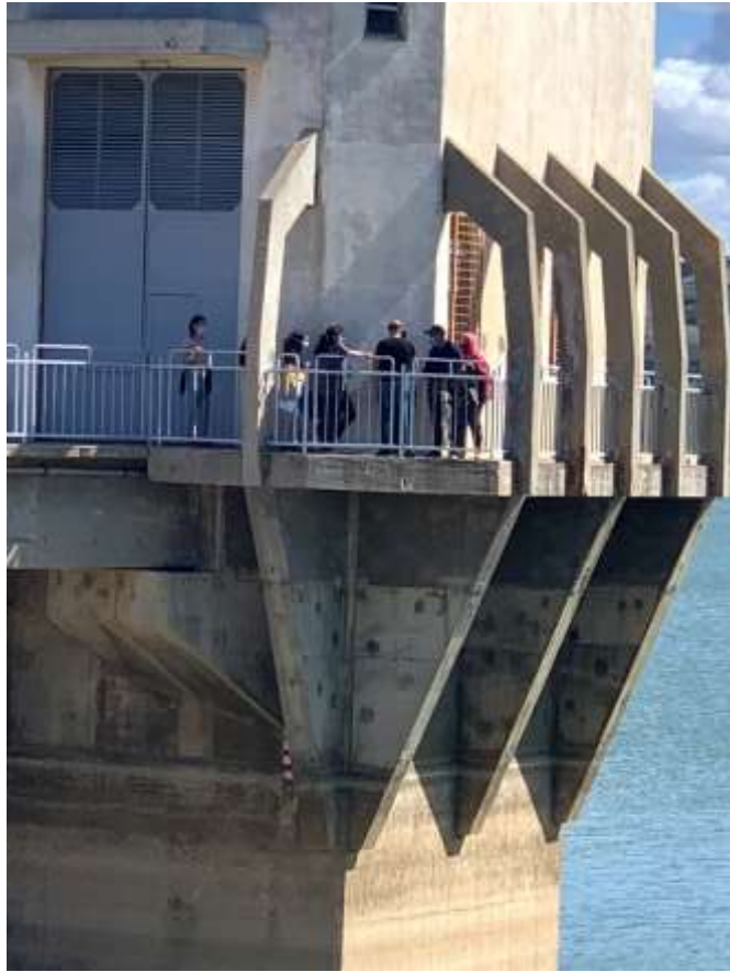
Le barrage de Sidi El Barrak
