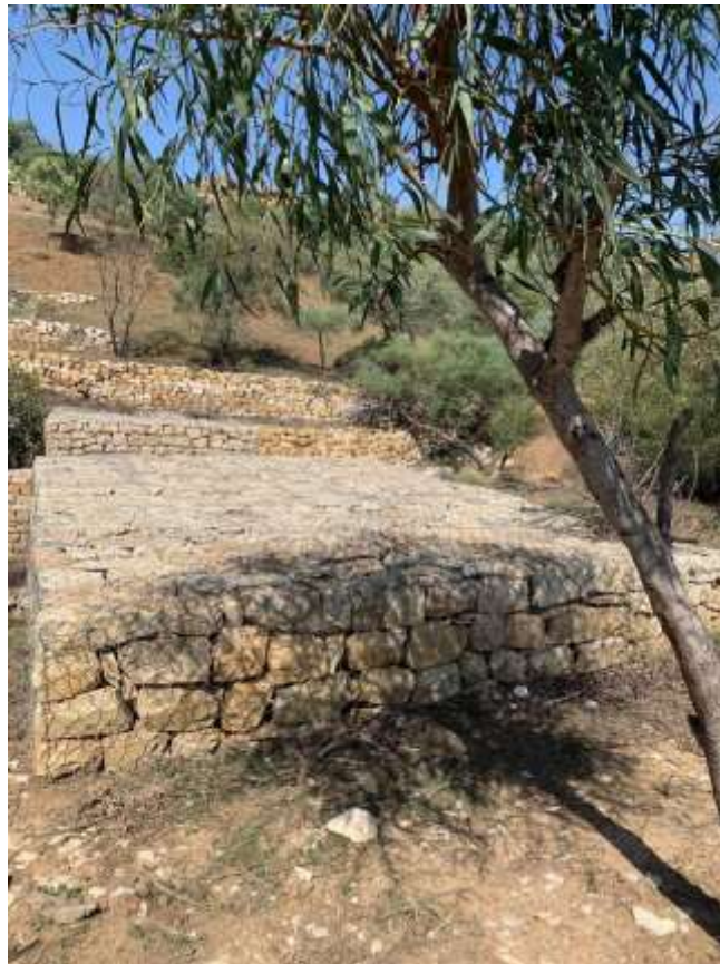
Seuil en gabion sur Oued El Khaïrat
